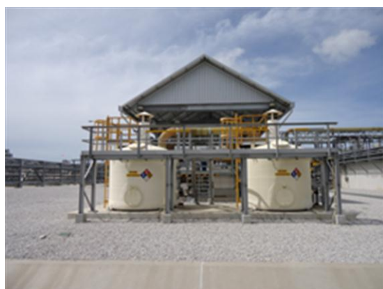
รูปที่ 3-32 ตัวอย่างการใช้ระบบ Activated Carbon Adsorber
