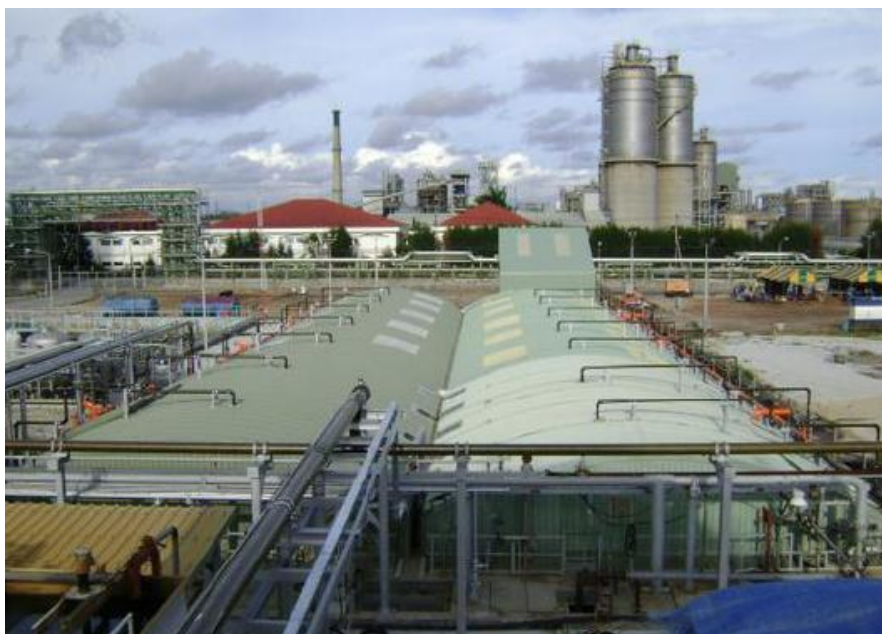
รูปที่ 3-29 การปิดคลุมระบบบำบัดน้ำเสีย
