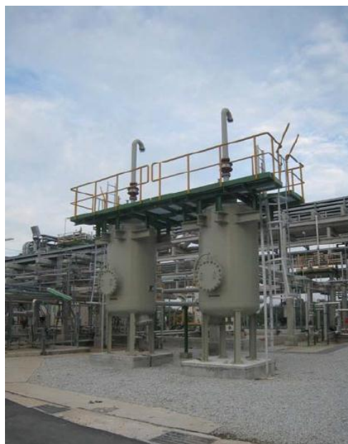
รูปที่ 3-21 ตัวอย่างการใช้ Charcoal Adsorber เพื่อดูดซับไอจากถังเก็บ
