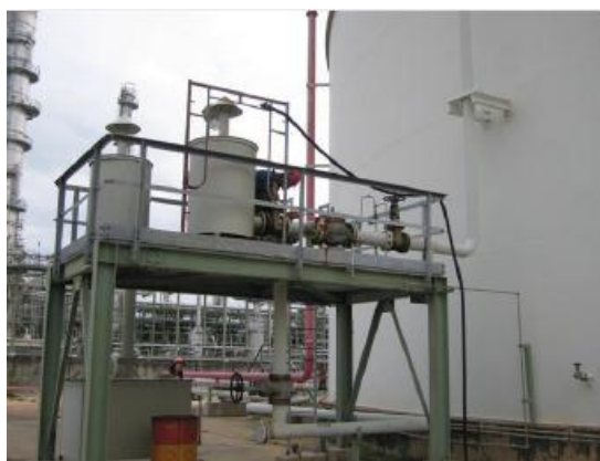
รูปที่ 3.17 ตัวอย่างการใช้ Charcoal Adsorber เพื่อดูดซับไอจากถังเก็บ
