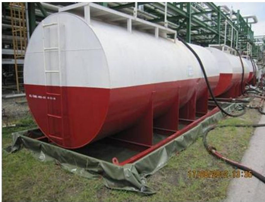
รูปที่ 3-34 ตัวอย่างการเตรียมภาชนะเพื่อบรรจุ VOCs ที่ตกค้างในระบบพร้อมระบบควบคุม ที่มา: บริษัท พีทีที โกลบอล เคมิคอล จำกัด (มหาชน)
