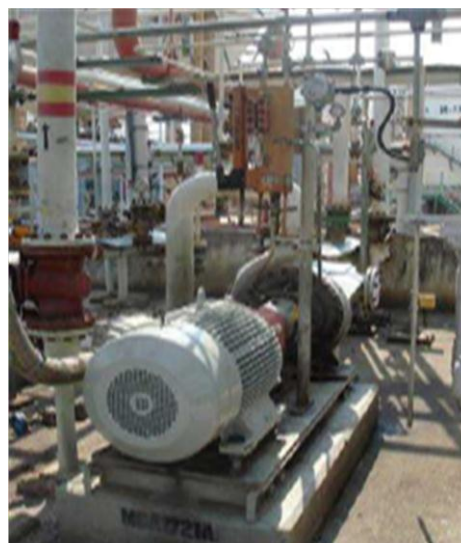
รูปที่ 3-12 การใช้ปั๊มชนิด double mechanical seal
