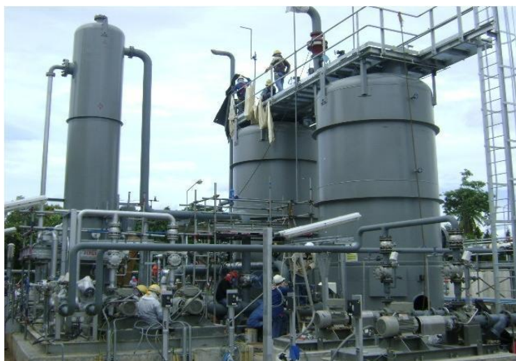
รูปที่ 3-18 ตัวอย่าง VRU ที่เทคนิคการดูดซับแบบ 2 ถึง
