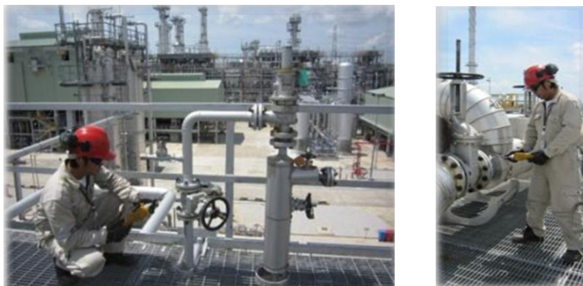
รูปที่ 3-3 การวัดสำรวจการรั่วระเหยและแก้ไขหรือซ่อมบำรุงในเวลาที่กำหนด
