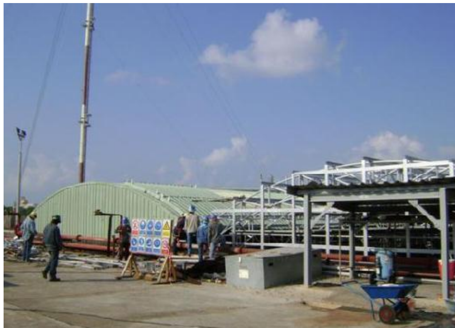
รูปที่ 3-28 การปิดคลุมระบบบำบัดน้ำเสีย
