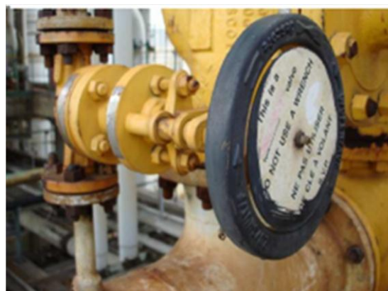
รูปที่ 3-10 วาล์วแบบไม่มีรอยต่อ
