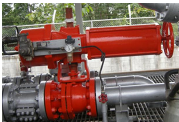
รูปที่ 3-9 วาล์วแบบไม่มีรอยต่อ
