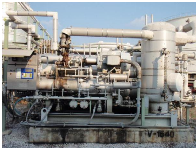
รูปที่ 3-20 แสดงตัวอย่าง VRU ซึ่งใช้เทคนิคการควบแน่น (Condensation)
