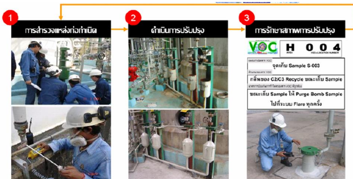
รูปที่ 3-2 การทำฝาปิดที่จุดเก็บตัวอย่าง เนื่องจากได้กลิ่น VOCs ขณะเดินสำรวจ
