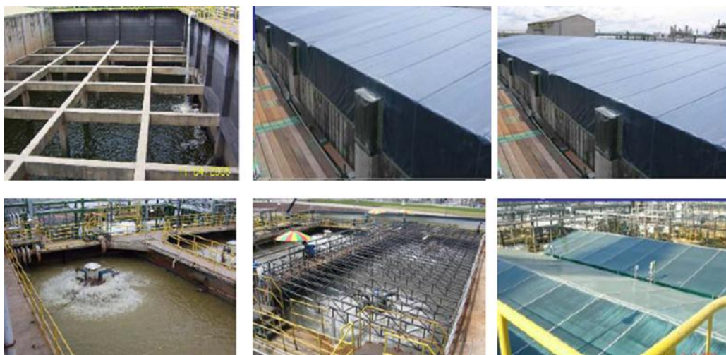
รูปที่ 3-27 การปิดคลุมระบบบำบัดน้ำเสีย
