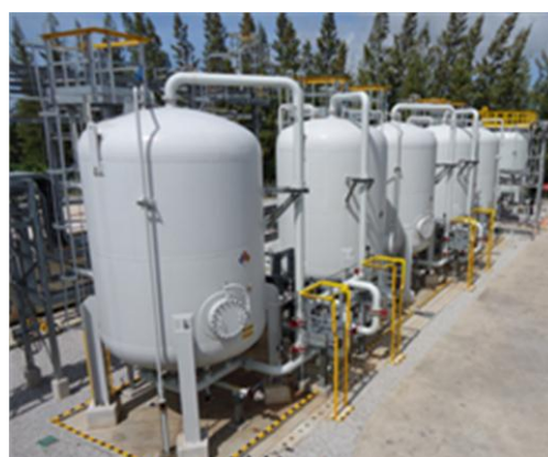
รูปที่ 3-32 ตัวอย่างการใช้ระบบ Activated Carbon Adsorber
