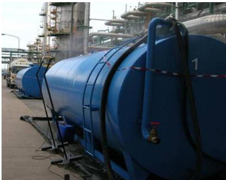
รูปที่ 3-36 ตัวอย่างการทำ De-contamination โดยการติดตั้งอุปกรณ์ Spray
